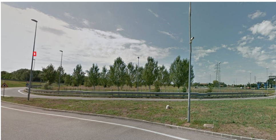
corsia di uscita su Viale dei Trattati di Roma
